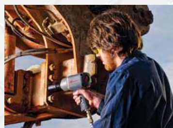
Lắp ráp và tháo gỡ máy móc và thiết bị nặng
